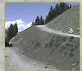
Inerbimento di scarpate
